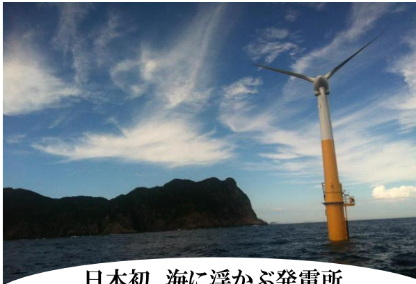
日本初 海に浮かぶ発電所 五島沖で浮体式洋上風力発電の実証事業
